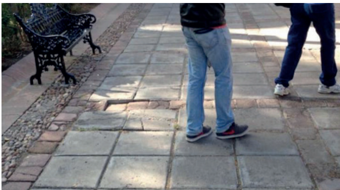
Imagen 94. Estado físico del espacio. Fuente: CAEUOT.
